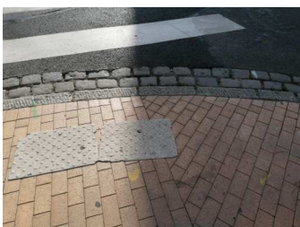
Bandes podotactiles abimées
