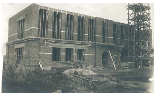
La brasserie en construction (1920).
